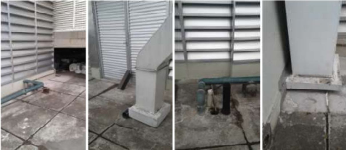
Laje de cobertura
