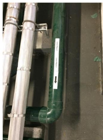
A nova linha deverá ser de PVC marrom e encaminhada até a entrada do Sistema de Osmose Reversa de forma a ficar apoiada nos batentes de concreto existentes (que apoiam as linhas existentes).
