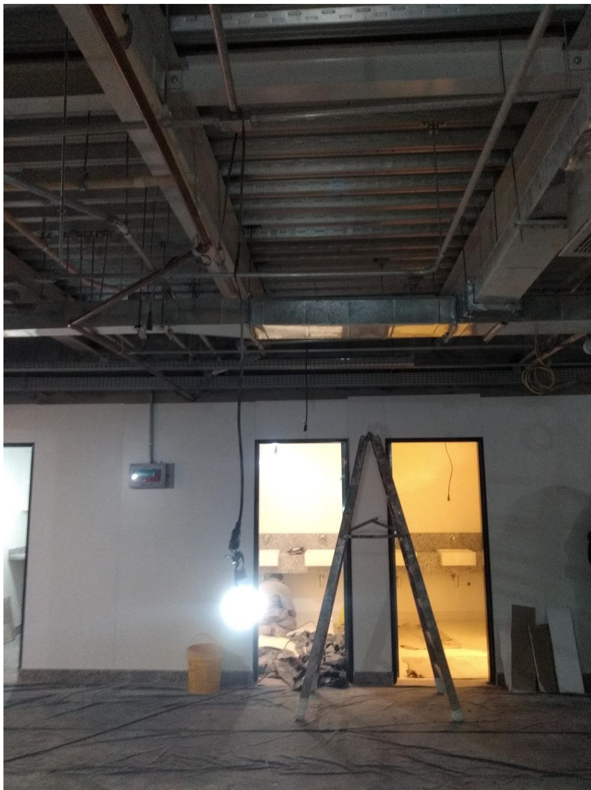
FOTO 03 – (Trecho principal de duto a ser mantido)
