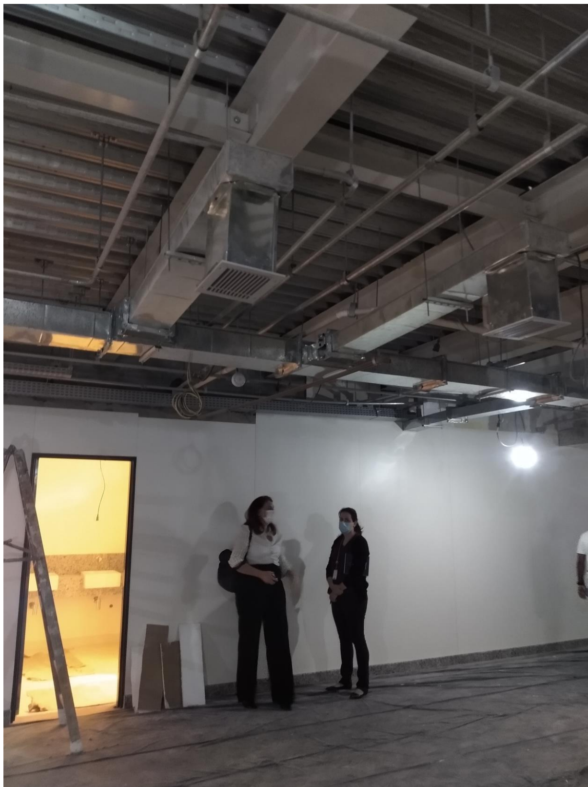
FOTO 04 – (Trecho de duto a ser removido e grelhas a serem remanejadas)
