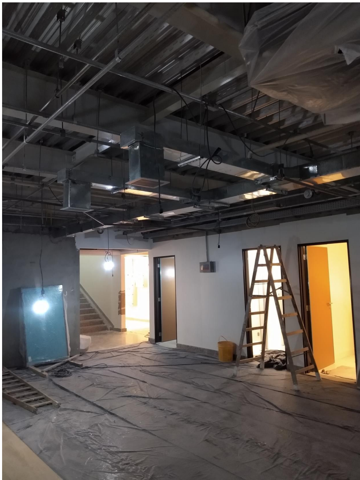
FOTO 01 – (Grelhas existentes a serem remanejadas e trechos de dutos a serem removidos)
