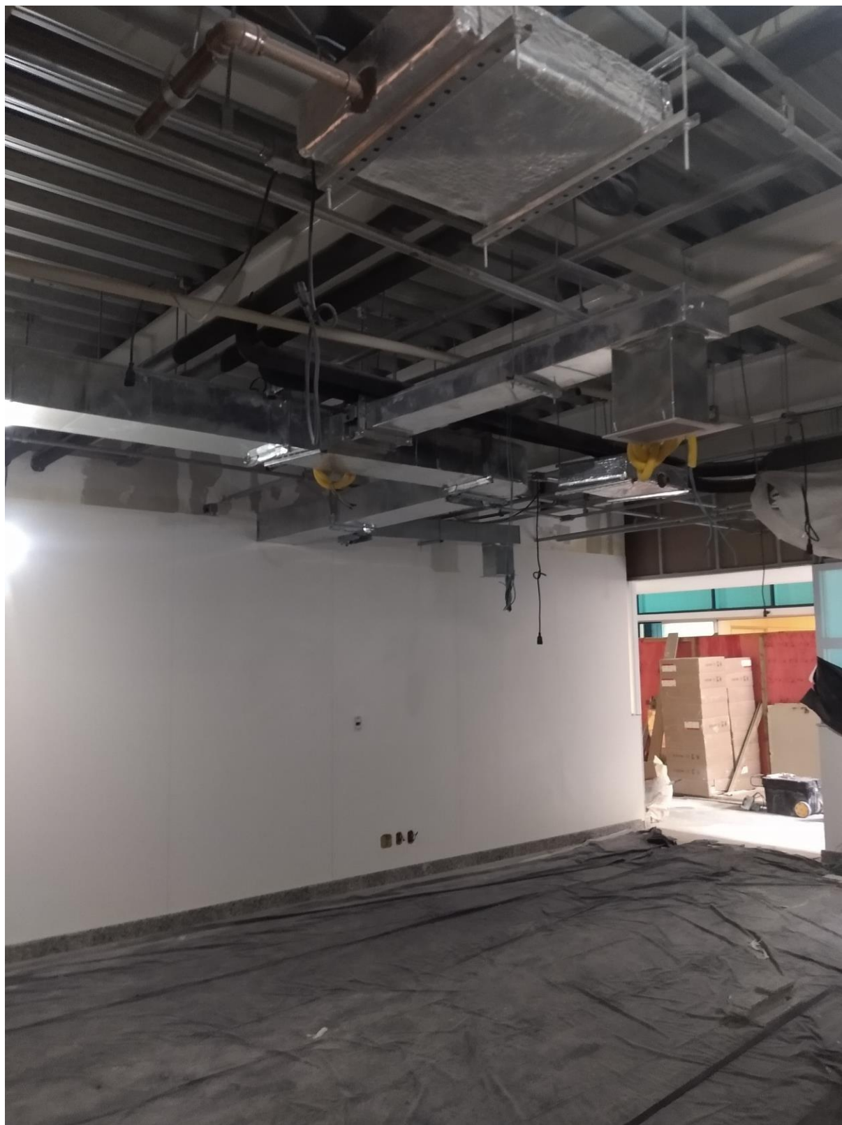
FOTO 02 – (Trecho principal de duto a ser mantido e grelhas a serem removidas)
